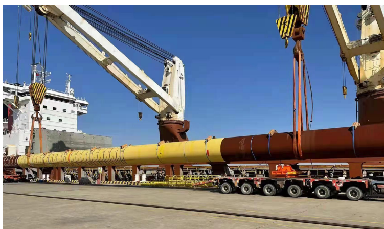
▲第三船 LNG 码头大型桩管正在装船
