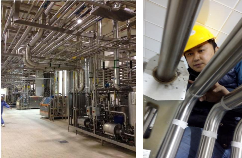
图 1 ASME BPE 标准指导设计安装的乳品工厂洁净管道系统
