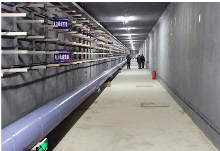
金洲管道积极进军地下管廊建设领域
